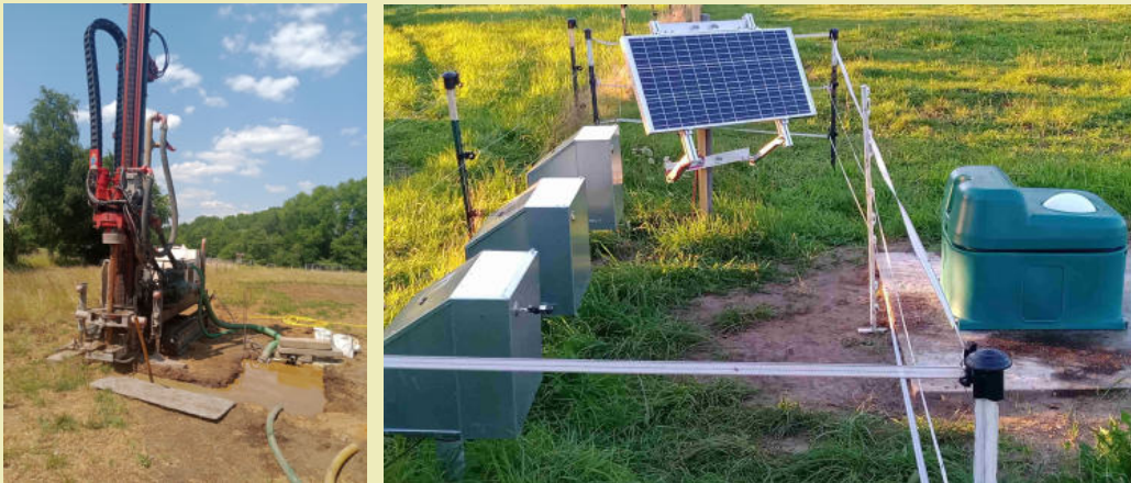
Ein eigener Tiefbrunnen und autarke Solarstromversorgung auch der Balltränke
