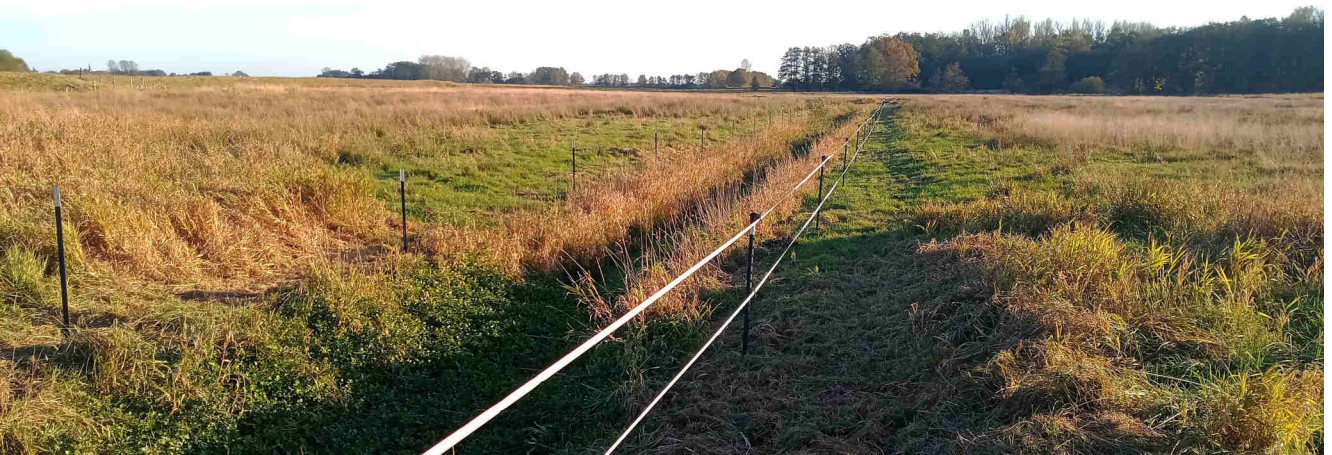
Weitere mobile Einzäunung des Verbandsgrabens Kollmoor Süd
